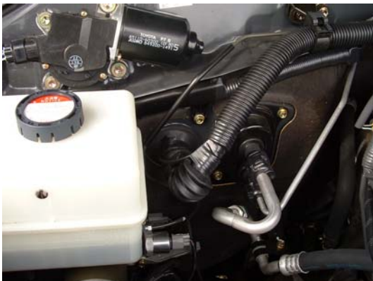
Passage des 2 câbles noirs
