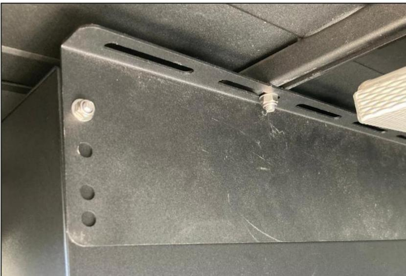
Une fois le support supérieur installé, vous pouvez régler les supports inférieurs. Assurez-vous qu'ils s'alignent avec les fentes du placard à baldaquin et qu'ils n'entrent pas en conflit avec les supports de montage de l'auvent.
